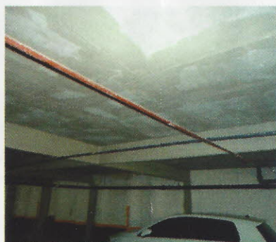
Escoramento com perfis metálicos
