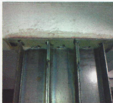
Escoramento com perfis metálicos
