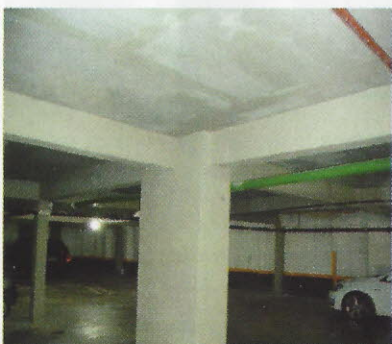
Vista geral do subsolo do edifício após reparos
