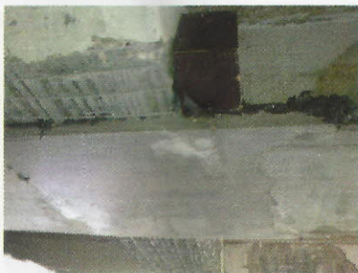
Grauteamento na posição mais crítica, no nível da transição, para permitir o apoio do escoramento metálico
